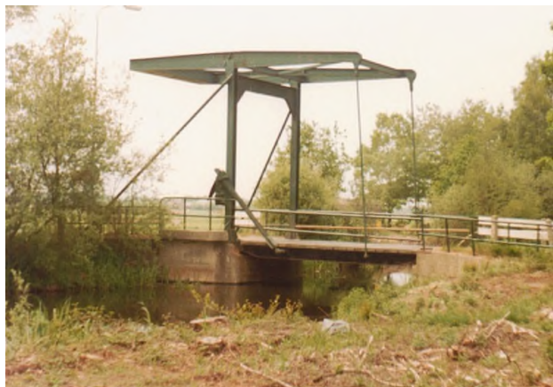
• De Lage Brug
