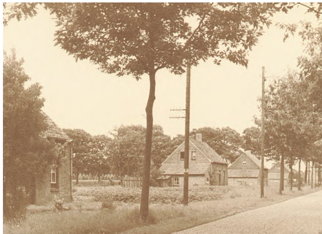
• Hun 1 e (peelwerkers)huisje aan de Kanaalweg in Griendtsveen
