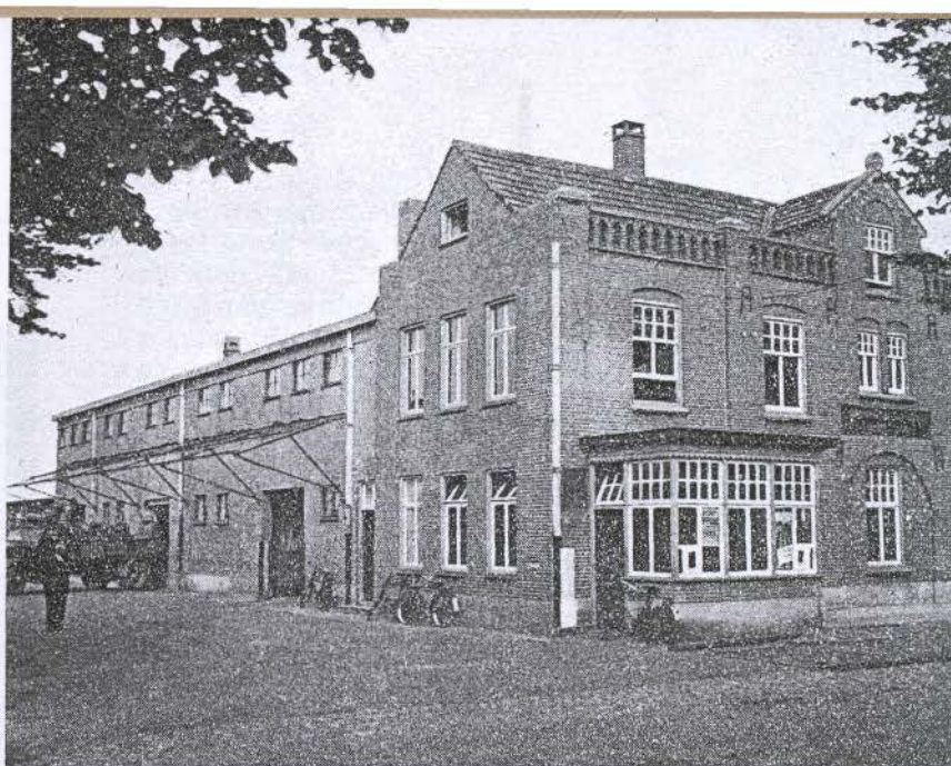
Hoofdmagazijn van den Boerenbond met annex kantoren van Boerenbond, Boerenleenbank en V.V.O.
