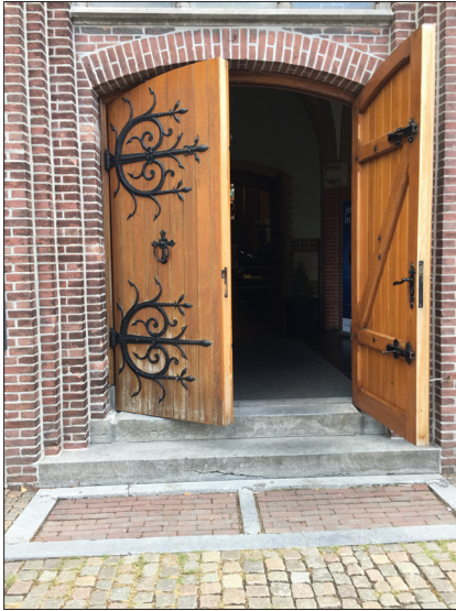
Afbeelding 8. Voor de kerkdeur in de Sint-Jozefparochie. Het rooster voor de deur is tegenwoordig geplaveid met klinkertjes.
